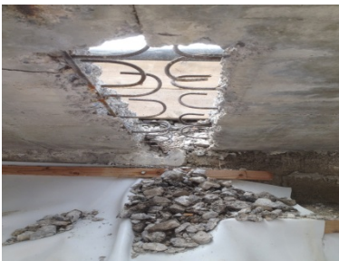
Fugen jetten mit beschränkten Platz Verhältnissen
