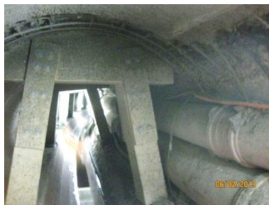
Letzte Etappe nach Umsetzung prov. Rohre
