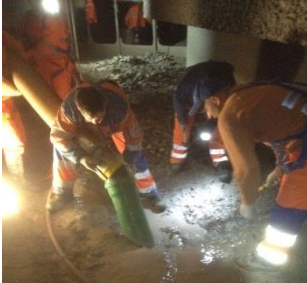
Saugarbeiten bis zu 60m Distanz
