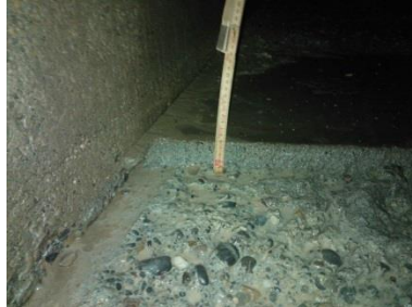
Überzug musste abgetragen werden inkl. Beton aufrauen
